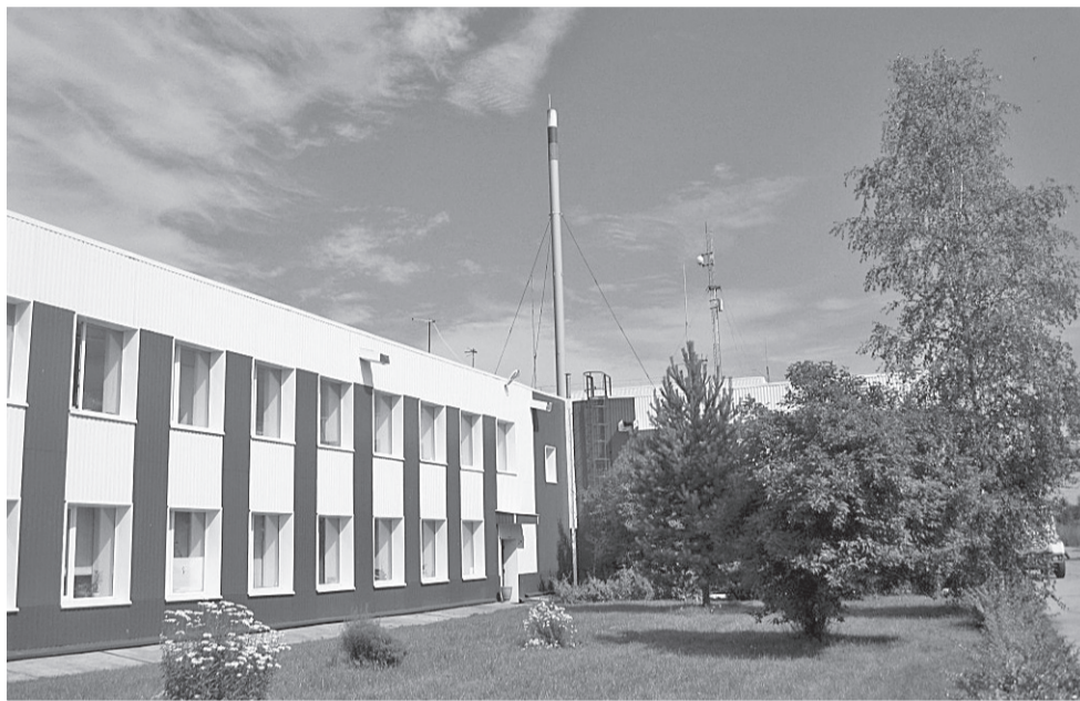
Административно-бытовой корпус полигона «Красный Бор»
