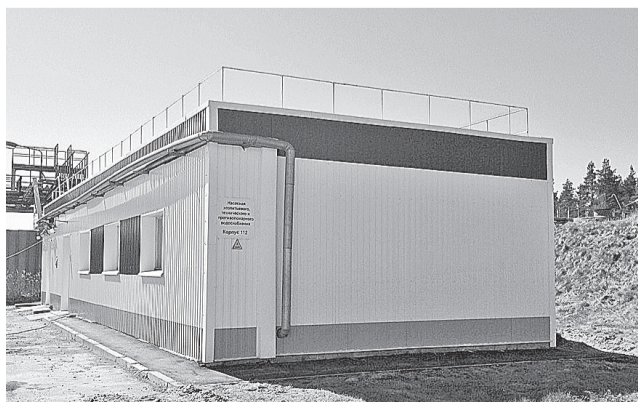
Главная насосная станция
